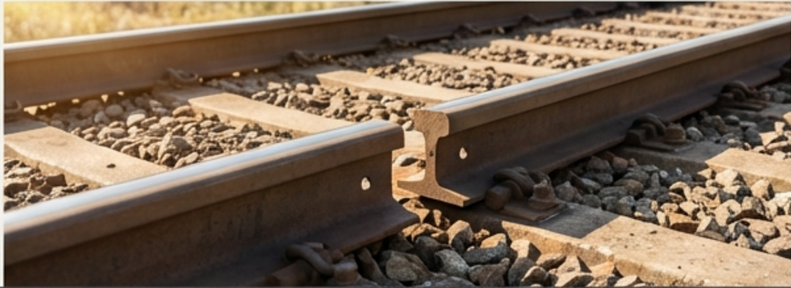
Trilhos de Trem: Espaços projetados para evitar deformações no calor.
